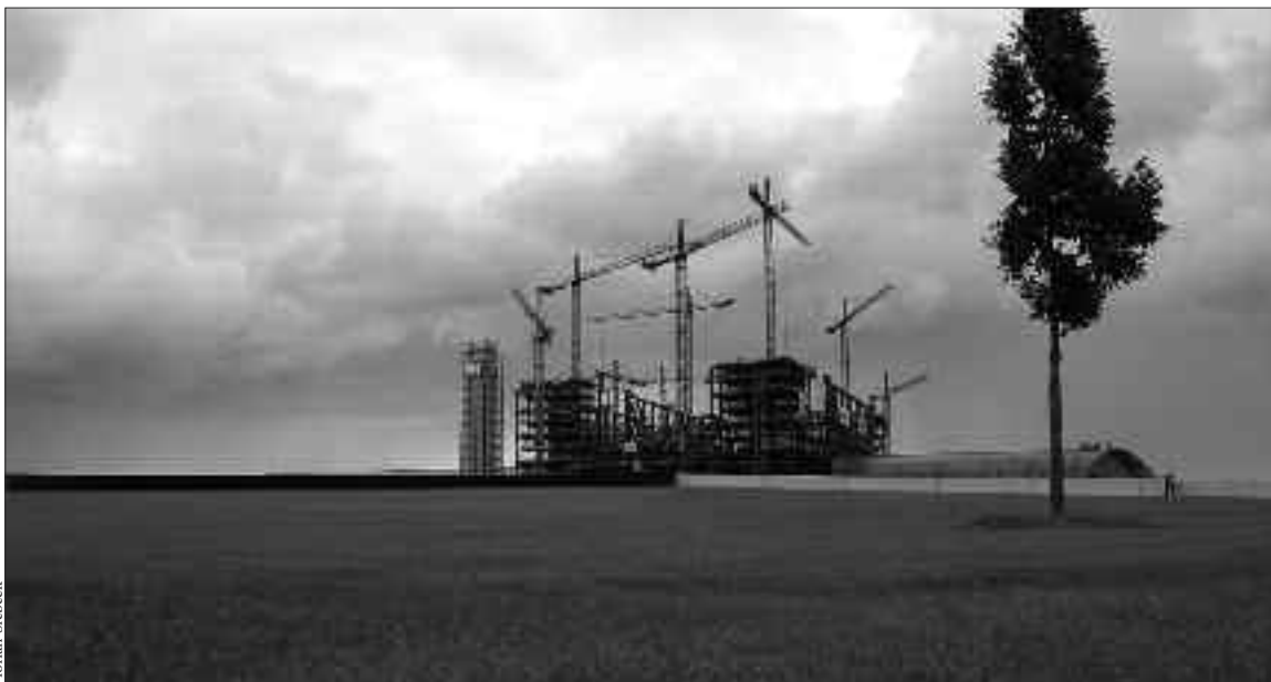
Ansicht eines Hauptbahnhofs (im Bau, 2005).
