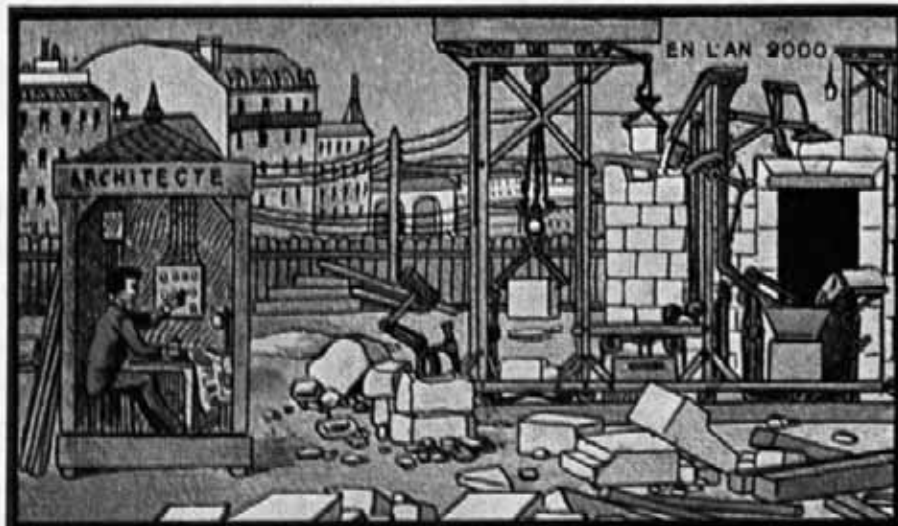
Chantier de Construction électrique
